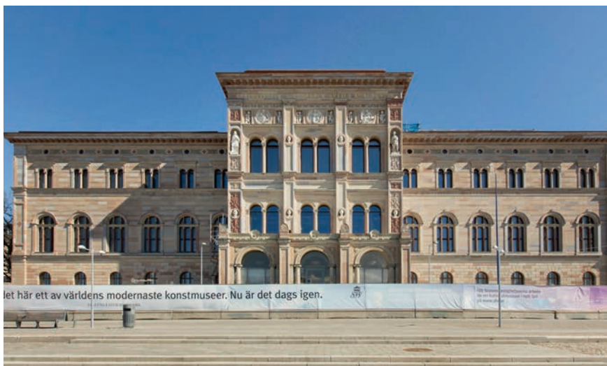
Totalrenoveringen av det statliga byggnadsminnet Nationalmuseum i Stockholm har pågått sedan 2014.
